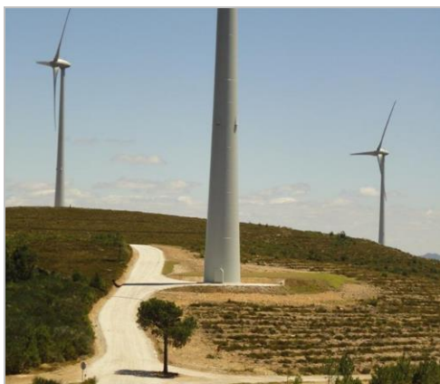
Foto 1. 1 – Plataforma dos aerogeradores
