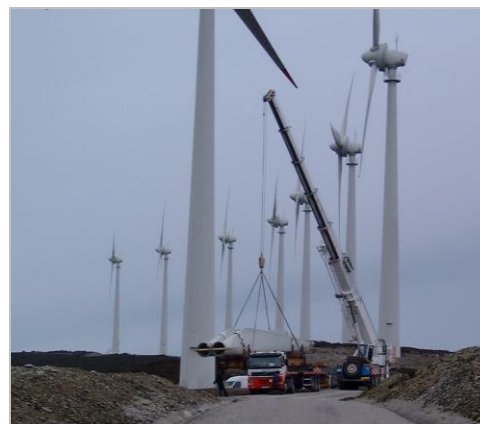
Foto 1. 2 – Acesso do parque utilizado como plataforma para realização de manutenção
