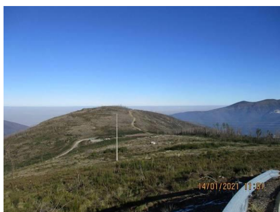
Foto 1. 9 – Vista para local de implantação dos aerogeradores
