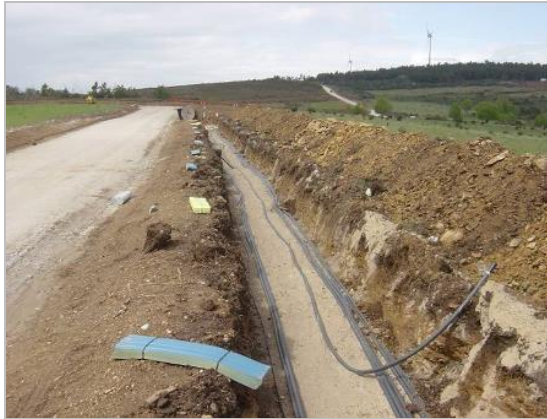
Foto 1. 3 – Vala para instalação de cabo (ao longo da berma direita de acesso)
