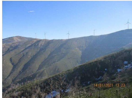
Foto 1. 12 – Vista para corredor da linha elétrica aérea (Encosta da Amieira e de Fonte Peão)
